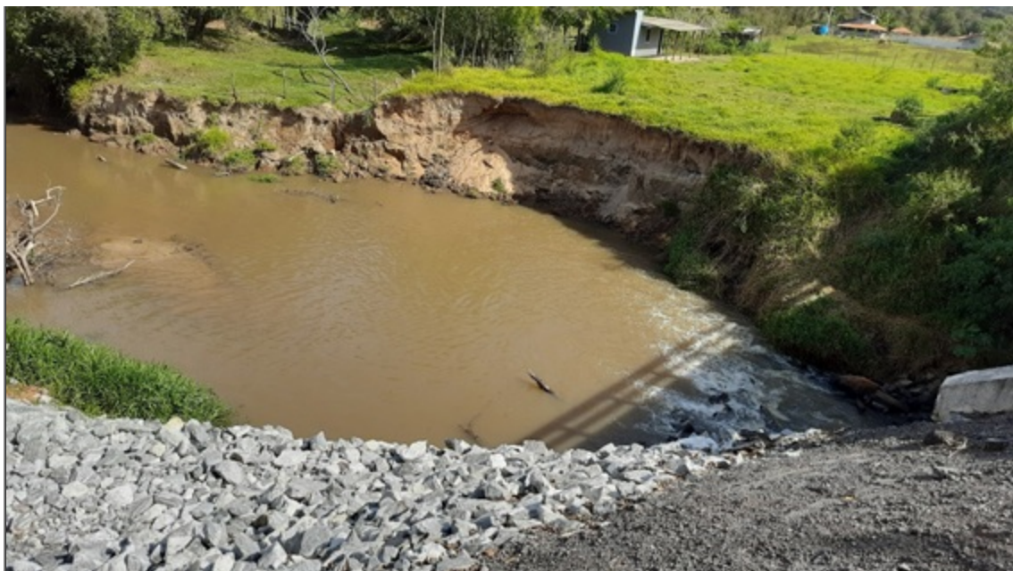
FIGURA 05: Imagem das obras de contenção e estabilização do talude de aterro de ponte existente na rodovia MG-290, situada no km 20+780 m, município de Borda da Mata/MG.
