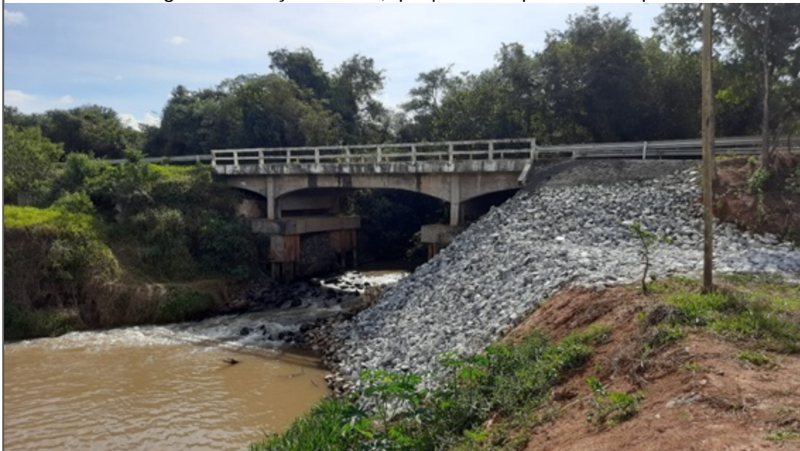
FIGURA 04: Imagem das obras de contenção e estabilização do talude de aterro de ponte existente na rodovia MG-290, situada no km 20+780 m, município de Borda da Mata/MG.
