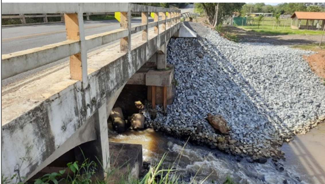
FIGURA 08: Imagem das obras de contenção e estabilização do talude de aterro de ponte existente na rodovia MG-290, situada no km 20+780 m, município de Borda da Mata/MG.
