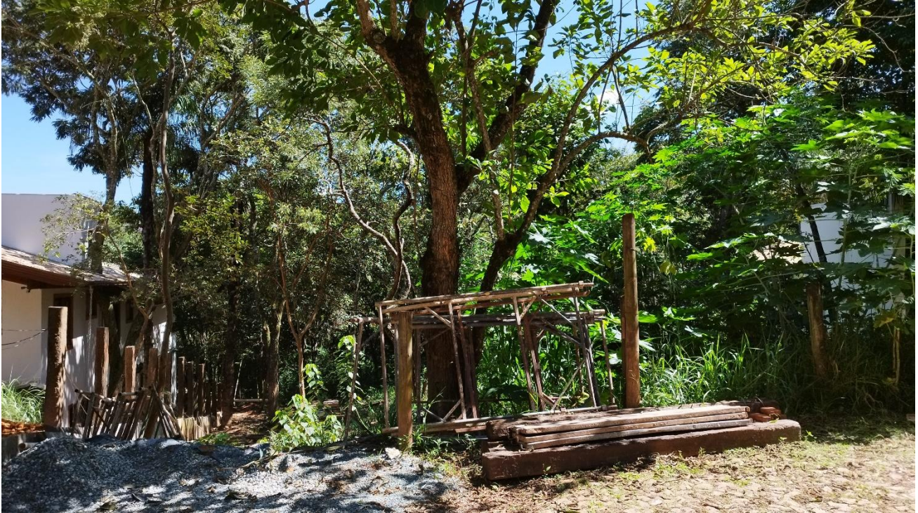
Imagem I - Vista Parcial da Faixada Frontal do Lote 11 Quadra 07
