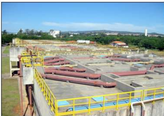
Vista parcial dos reatores UASB.
