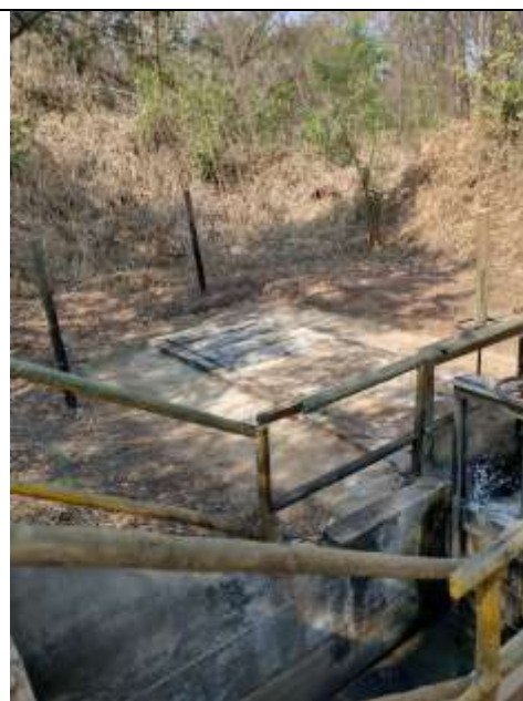
Foto 04: Dissipador de Energia
