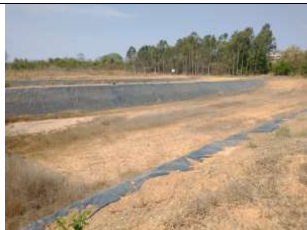
Foto 07: Aterro para resíduos industriais
