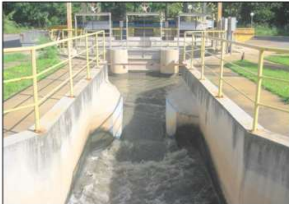
Calha Parshall e medidor de vazão
