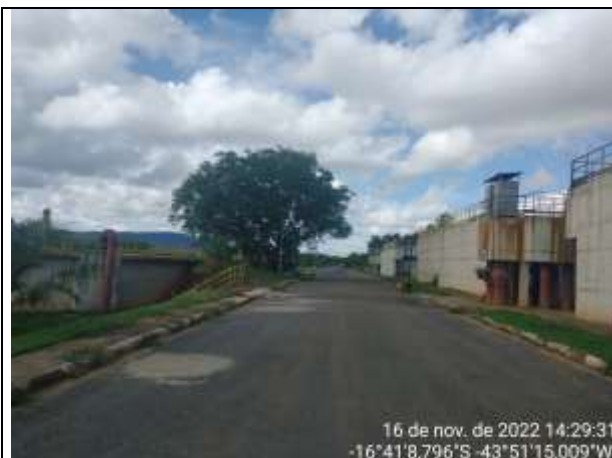
Foto 01. Vista geral dos reatores e filtros biológicos
