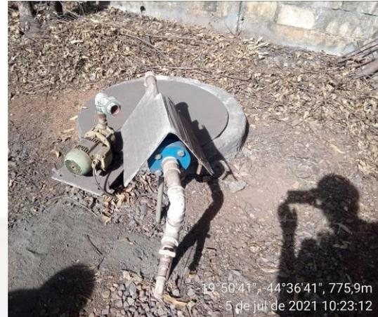
**Foto 08.** Captação subt. (poço manual)
