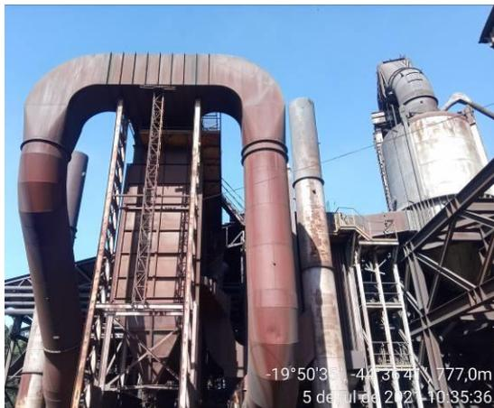
**Foto 01.** Sistema limpeza gases da aciaria.
