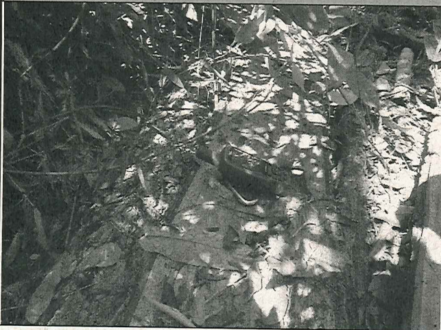
Foto 01: Madeira traçada irregularmente.
