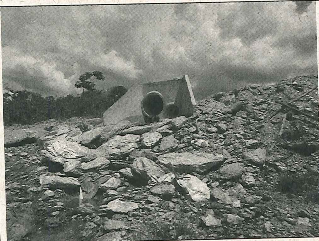
Foto 07: Intervenção em APP.
