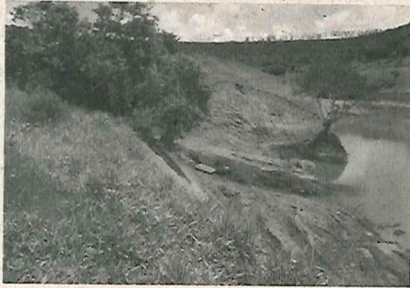
Foto 01: Área de intervenção- entrada água no barramento
