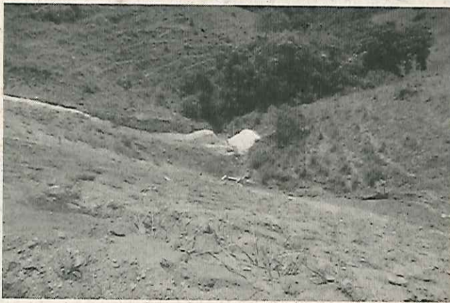
Foto 03: Saída de água pelo vertedouro
