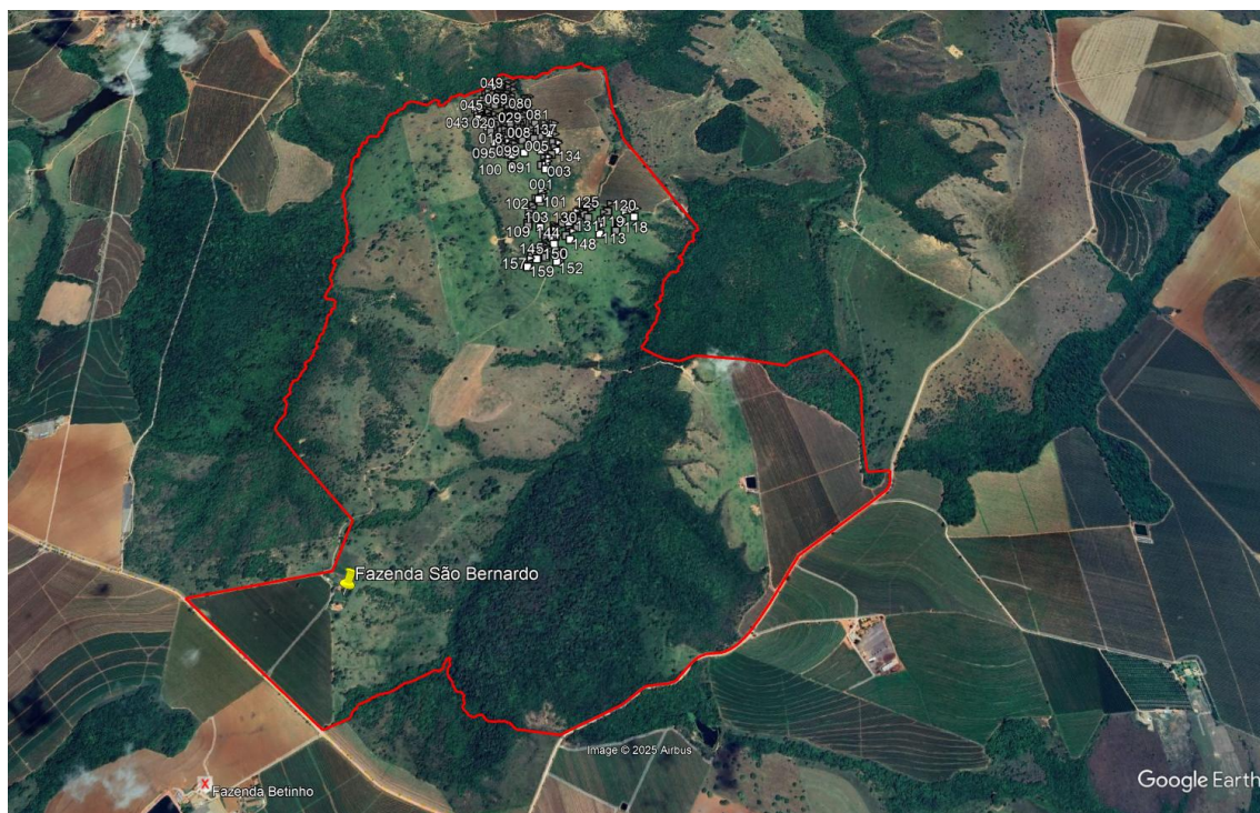
Figura 1: Pontos das Árvores isoladas.
