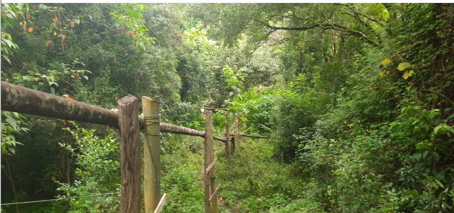
FIGURA 08: Imagem da tubulação de sucção, em APP, já instalada na propriedade Sítio Santo Antônio, Bairro Santo Antônio, município de Tocos do Mogi/MG.
