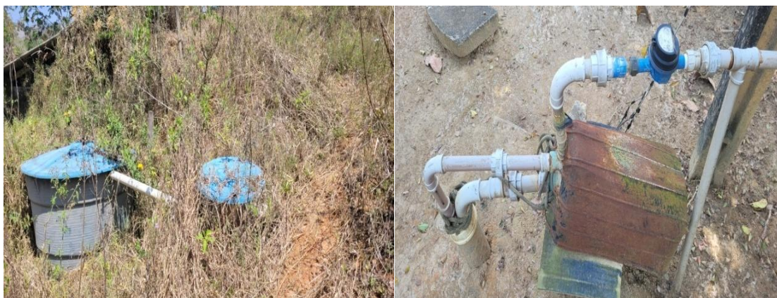
Figuras 11 e 12: sistema fossa/filtro e poço tubular utilizados pela ASCAR.
