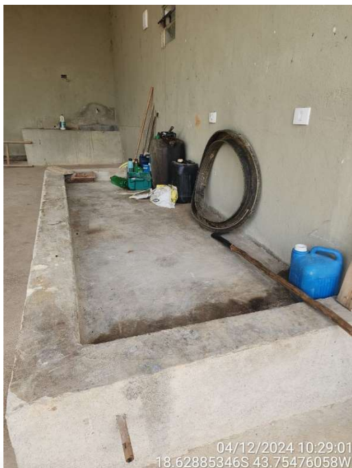
21: Tanque de contenção de resíduos e efluentes industriais
