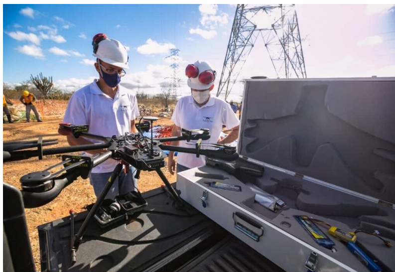
Figura 14 – Exemplo de drone para o lançamento de cabos.
