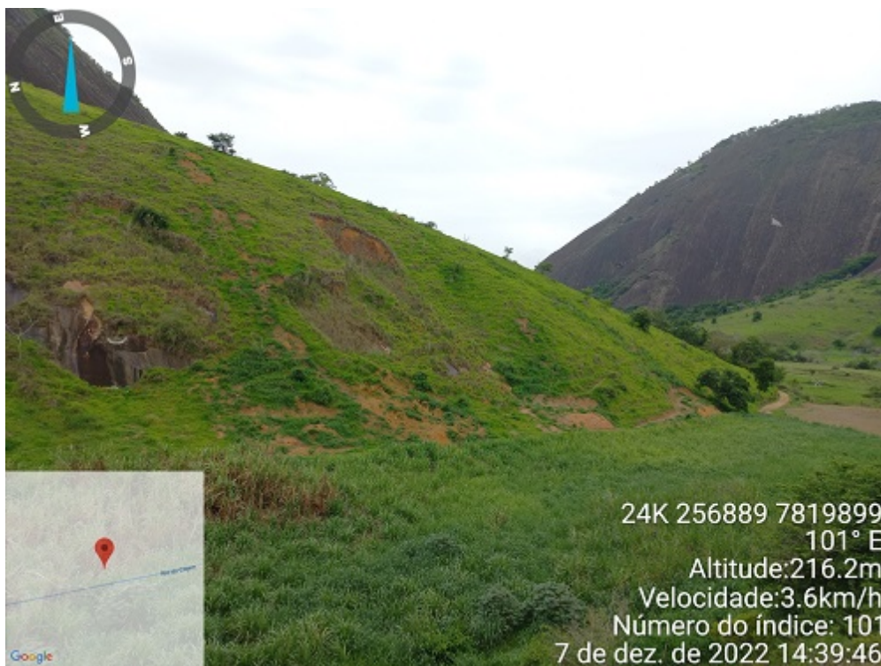
Vista da ADA, com as intervenções realizadas em APP. Fonte: IEF
