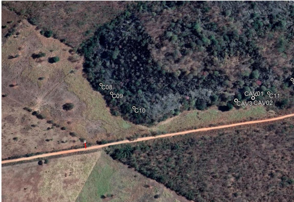
Figura 13 Localização das cavidades em relação ao bueiro (linha na cor vermelha e branca) localizado na estaca 551.
