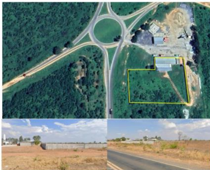
Figura 4 Local onde estará implantado o canteiro de obras (fonte: informações complementares, 2022)
