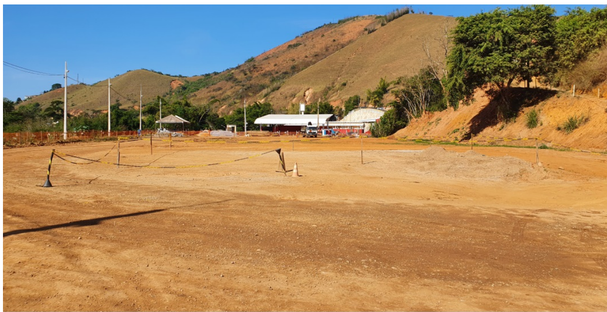
Área de disposição de material retirado da limpeza da zona urbana de Barra Longa onde será construído o novo Campo de Futebol dos Rodoviários.
