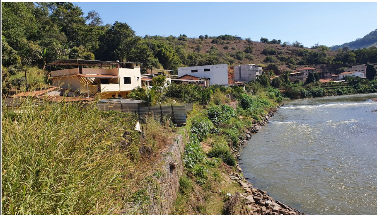
Instalação de gabiões na margem direita do Rio do Carmo.
