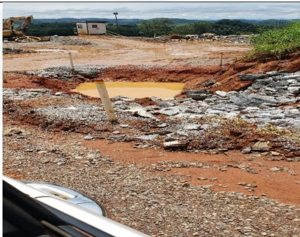
Foto 03: Sump para acumulação da água da drenagem pluvial
