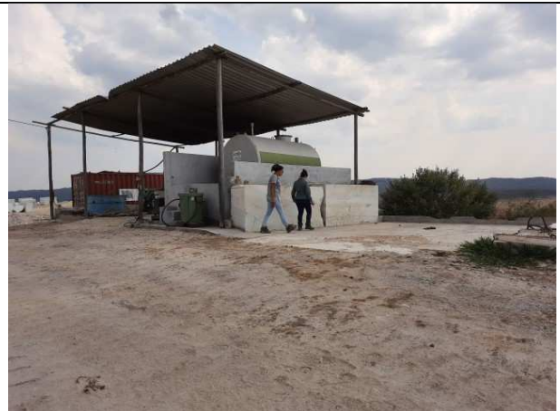
Estrutura de apoio frente Ártemis
