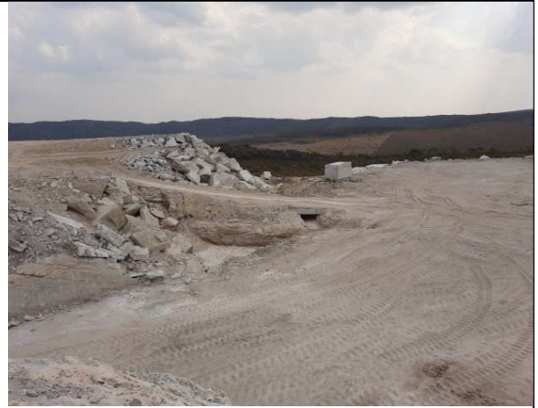
Pilhas de rejeitos em processo de conformação
