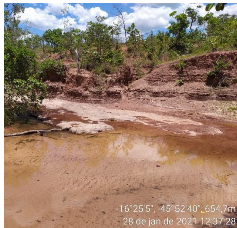
FOTO 02 – Ponto de intervenção para construção de barramento.
