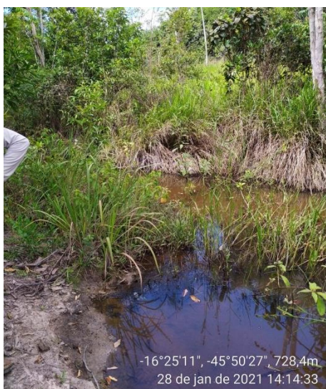
FOTO 03 – Ponto de intervenção para construção de barramento.
