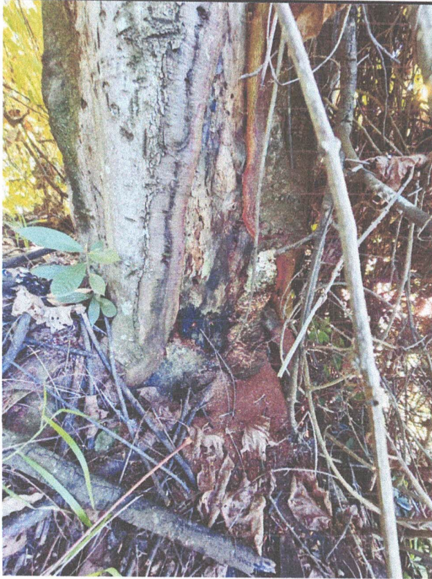
Foto 8 – Presença de broca e fungos na base do Guapuruvu.
