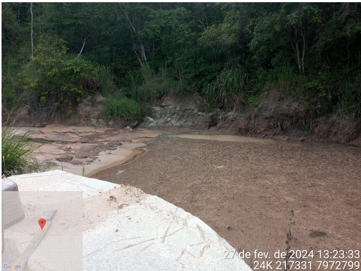
Imagem 5: Caixa de sedimentação.
