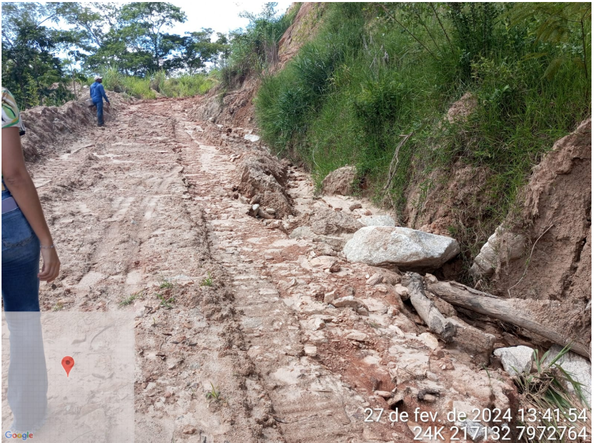
Imagem 4: Área da estrada, onde houve intervenção.
