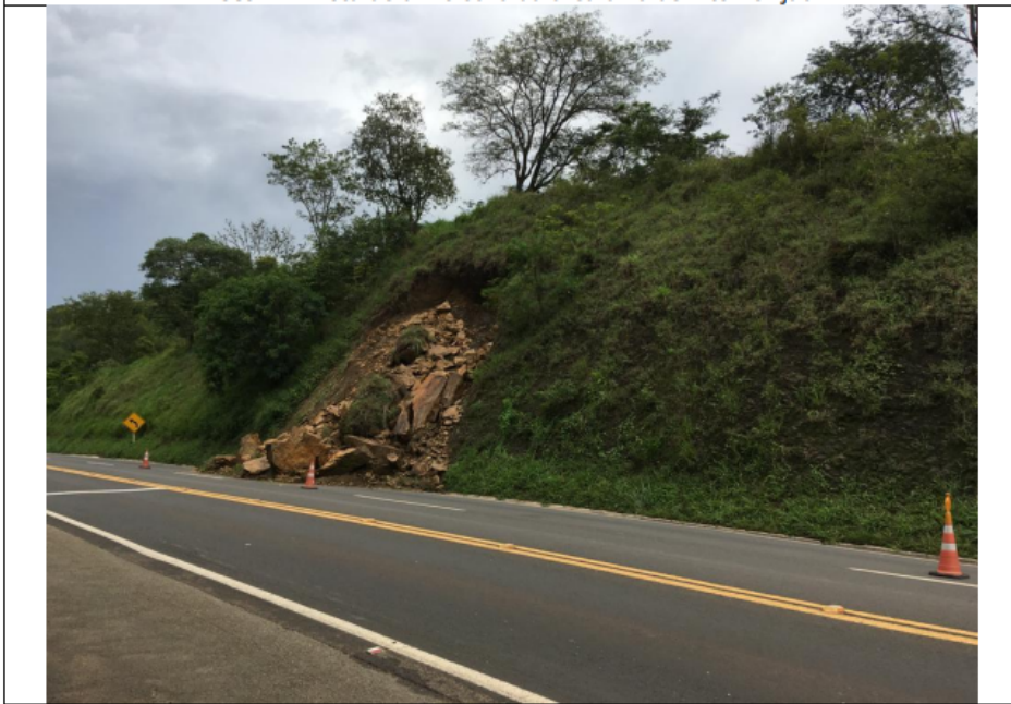
Foto 15. Vista de um trecho da área alvo de intervenção.
