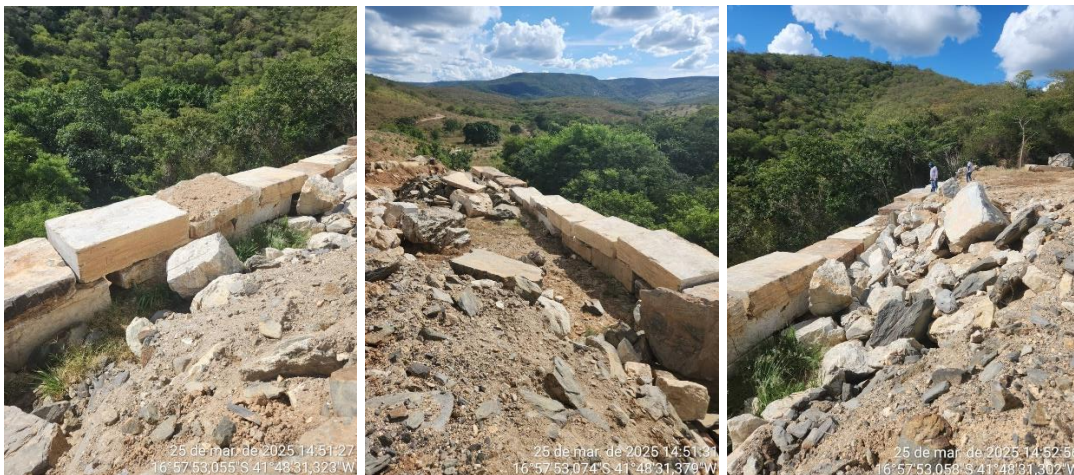
Fotos 9, 10 e 11 – Pátio de blocos e barreira de contenção em APP.
