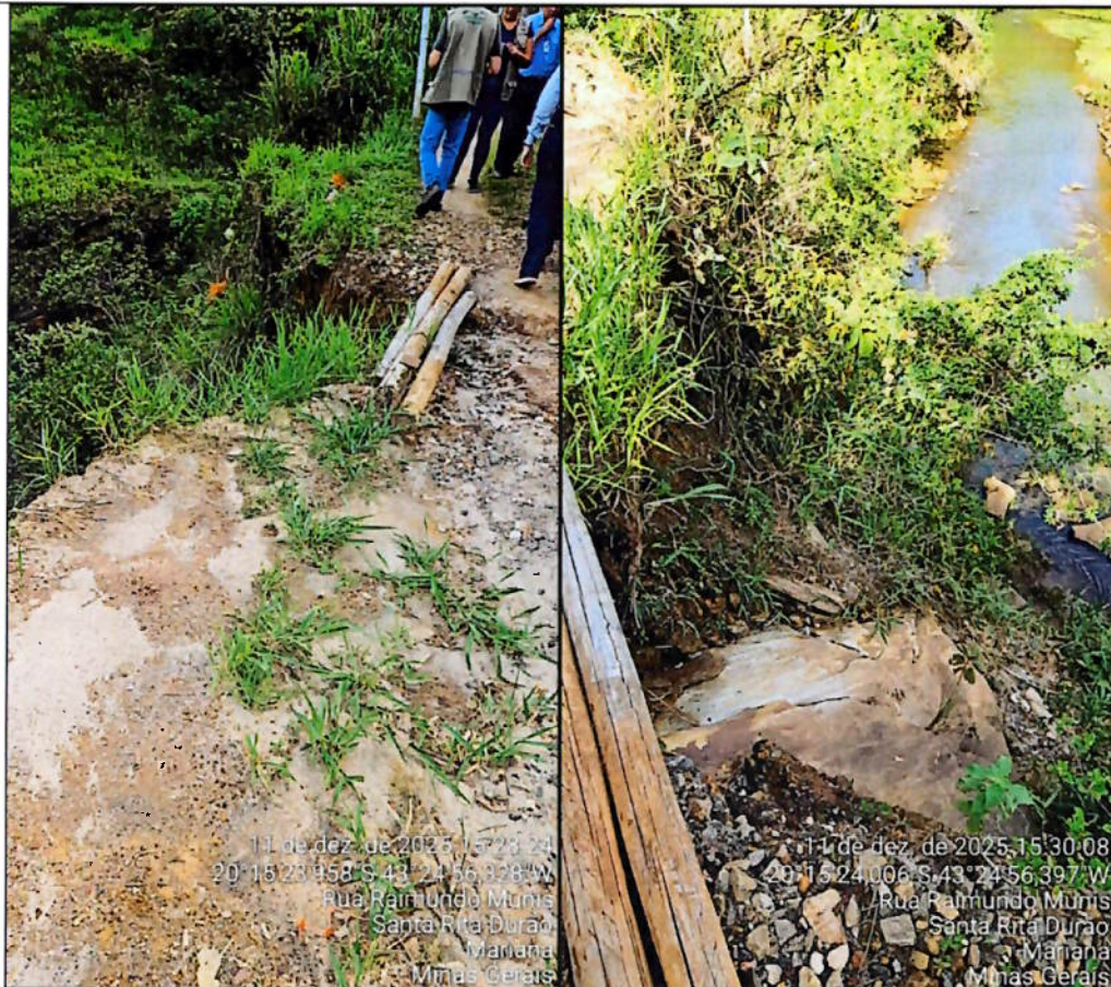
Figura 2. Fotos da área sujeita à intervenção, Mariana - MG. Fonte: Autor.
