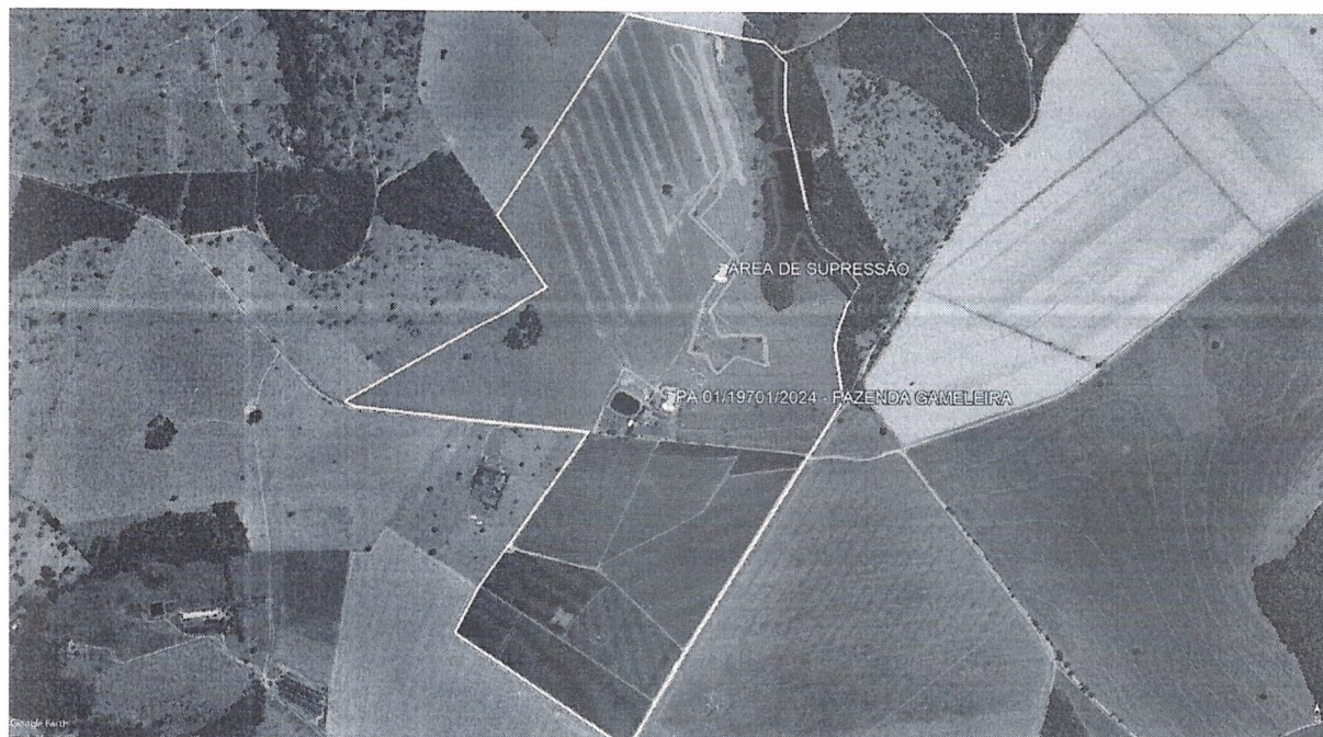
Figura 2 - Localização da Fazenda Gameleira (delimitação e marcador em amarelo), destacando-se as Áreas de Preservação Permanente – APP (delimitação em vermelho), as áreas de Reserva Legal (delimitação em azul escuro) e a área de supressão (delimitação em verde), para viabilizar a expansão das atividades agrossilvopastoris no empreendimento. Fonte: SEMAM / Google Earth, 2025.
