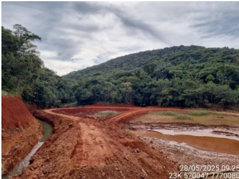
Figura 2: Estrutura temporária de desvio do fluxo de água para o vertedouro na ombreira direita da barragem
