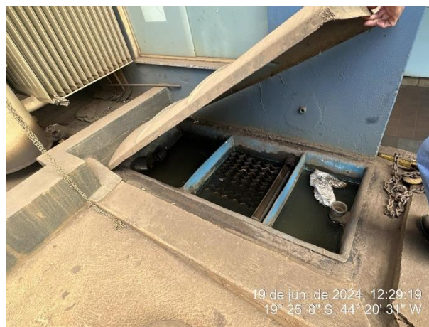
Foto 64: CSAO que recebe efluentes da oficina industrial e área dos compressores
