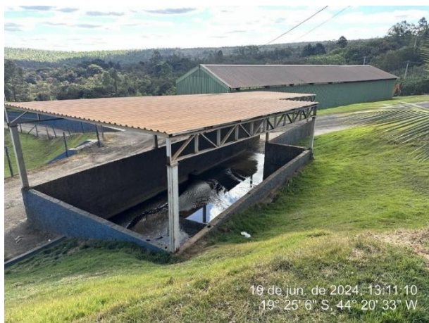
Foto 49: Área de chegada dos efluentes previamente à bacia de decantação
