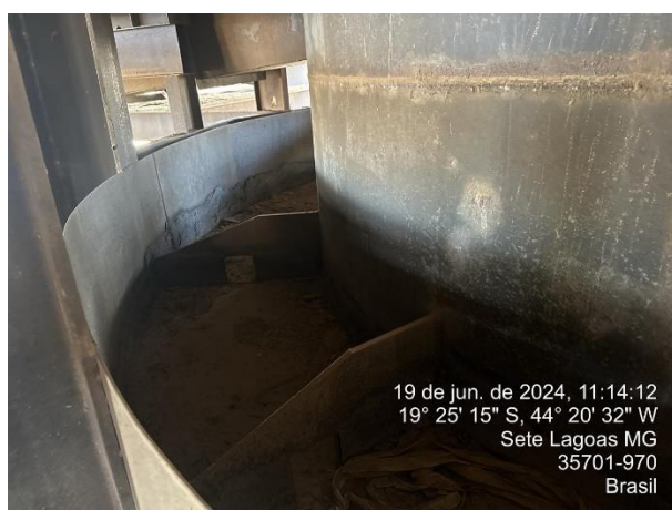
Foto 16: Estrutura de resfriamento do alto-forno 02
