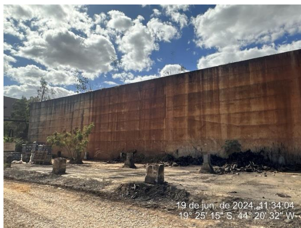
Foto 20: Arrimo que será a estrutura da área de recebimento de minério
