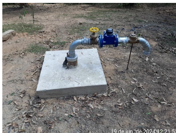
Foto 78: Local do poço com estrutura de concreto.
