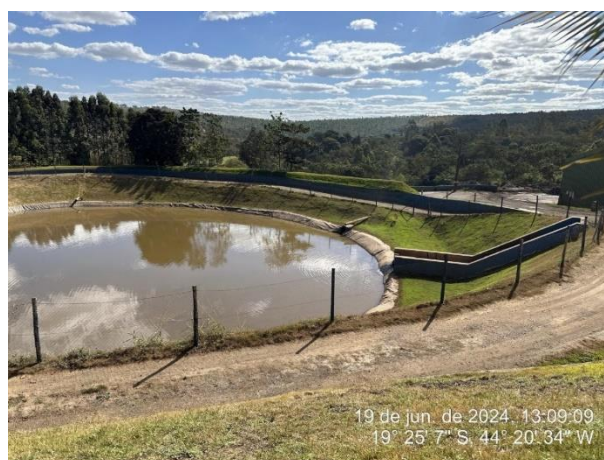
Foto 52: Bacia de decantação que recebe todo o efluente pluvial da empresa
