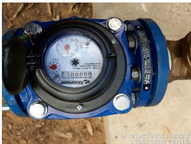
Foto 79: Hidrômetro instalado na saída de água do poço.
