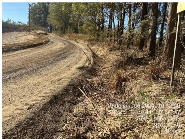
Foto 37: Canaleta na via de acesso ao pátio de minério próximo à área do alto-forno 02
