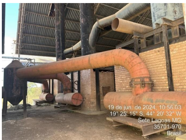
Foto 5: Detalhe da tubulação chegando nos glendons .
