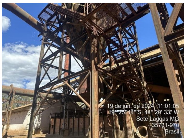
Foto 7: Estrutura do balão gravimétrico
