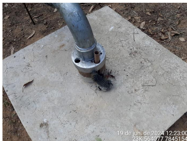
Foto 80: Detalhe da saída da tubulação do poço com o tubo de monitoramento de nível estático.
