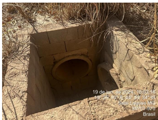
Foto 36: Caixa de recebimento de efluente pluvial que contempla sistema de drenagem da IFG. Essa estrutura se localiza nas vias de acesso ao alto-forno 02
