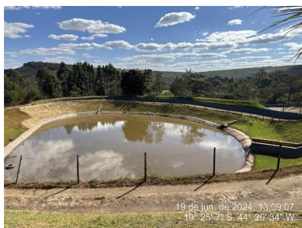
Foto 51: Bacia de decantação que recebe todo o efluente pluvial da empresa
