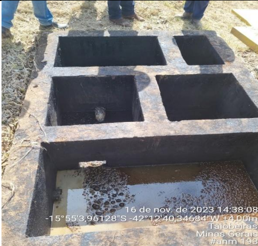
Figura 05: Caixa Separadora de Água e Óleo - CSAO Fonte: URANM, 2023.
