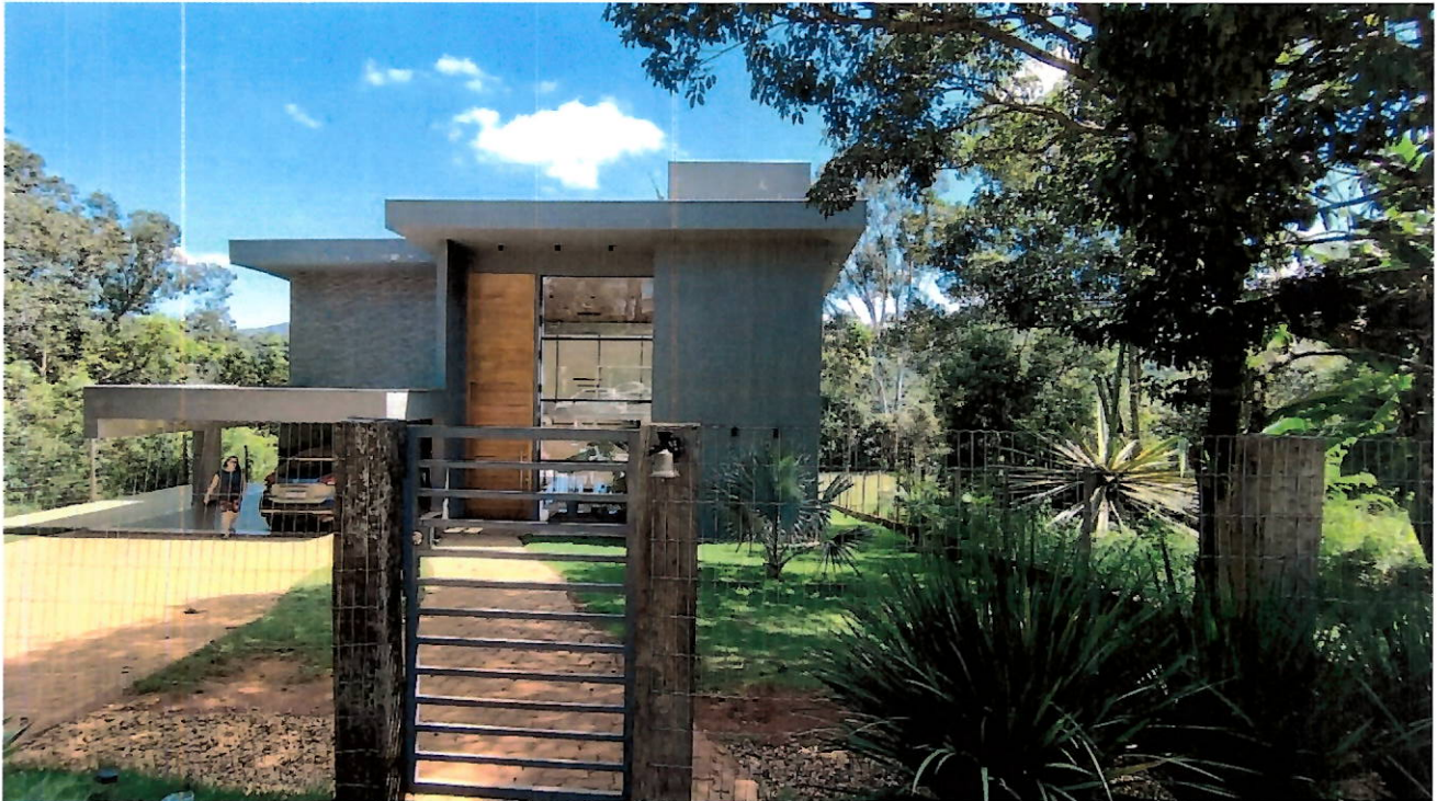
Imagem 1 - Vista da Faixada Frontal da Residência
