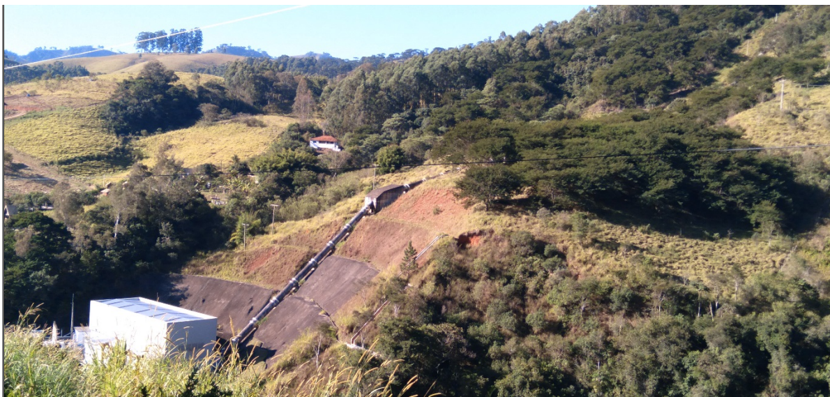
FIGURA 10: Panorâmica da Área Diretamente Afetada (ADA) do empreendimento PCH Ninho da Águia, Bairro Barreiro, município de Delfim Moreira/MG, com a imagem da Casa de Força.
