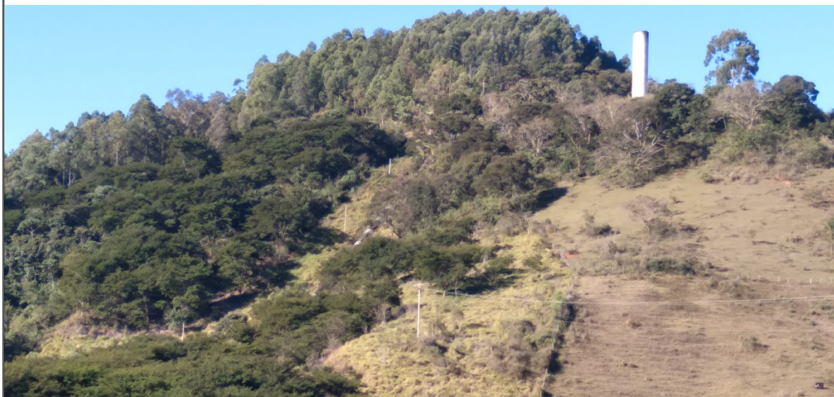
FIGURA 07: Local da intervenção ambiental (linha de distribuição de energia elétrica), com corte de árvores isoladas, presente na área do empreendimento PCH Ninho da Águia, bairro Barreiro, município de Delfim Moreira/MG.
