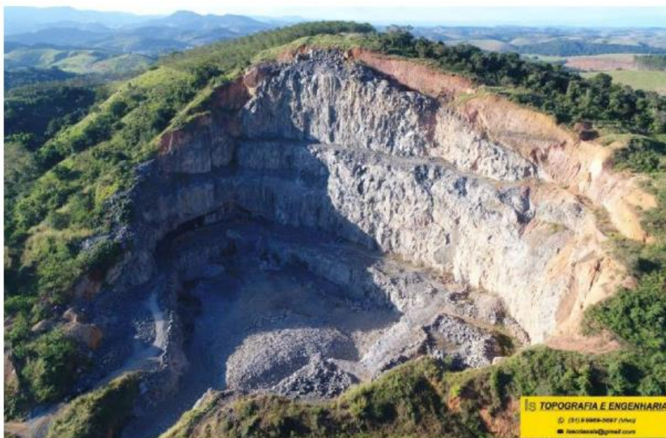
Vista da cava com lavra a céu aberto em bancadas na poligonal ANM 830.772/1982. Fonte: EIA/RIMA
