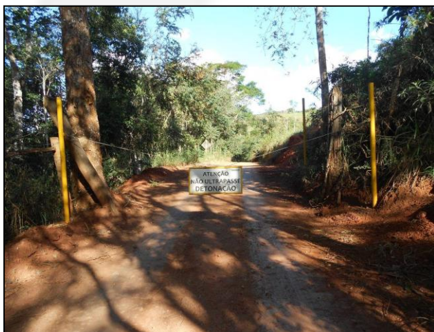
Foto 11 – Sinalização de bloqueio de via interna durante detonação. PCA (Belmont, 2020).
