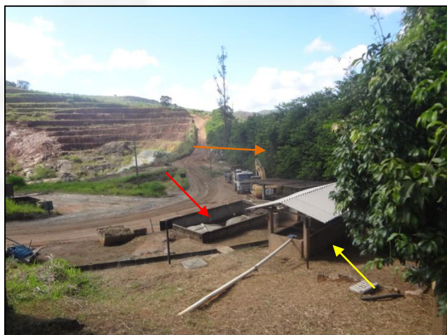
Foto 12 – Nesta foto é possível observar algumas medidas mitigadoras adotadas pelo empreendedor, sendo elas: cortinamento vegetal - seta laranja, sistema de tratamento do esgoto sanitário - seta vermelha (um dos três sistemas que o empreendimento possui) e caixa desarenadora/caixa separadora de água e óleo - seta amarela.
