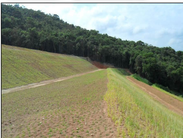
Foto 04 – Vista parcial da pilha de rejeito/estéril. Observa-se ações de recuperação nos taludes após a configuração final, tais como reconformação topográfica e plantio de gramíneas. Nota-se ainda o sistema de drenagem da estrutura, que potencializa sua estabilidade geotécnica. PCA (Belmont, 2020).
