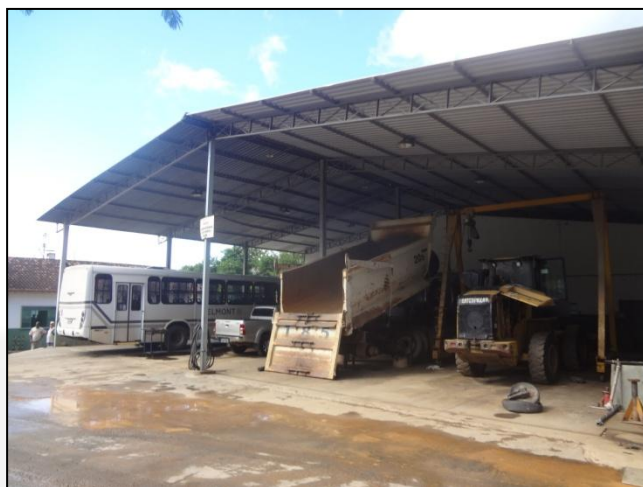
Foto 10 – Oficina para manutenção de máquinas e equipamentos.
