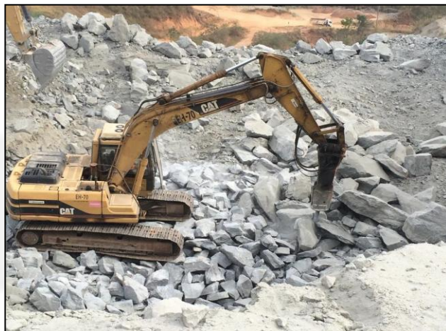
Foto 02 – Utilização de maquinário com rompedor hidráulico para quebra dos matacões de maiores dimensões. PCA (Belmont, 2020).
