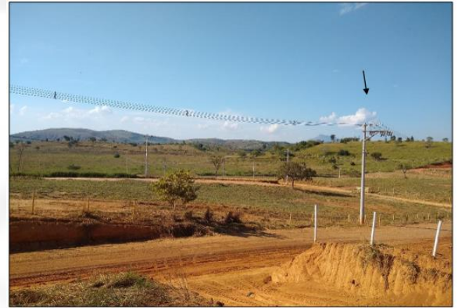
Foto 04. Vias internas e sistema de iluminação.
