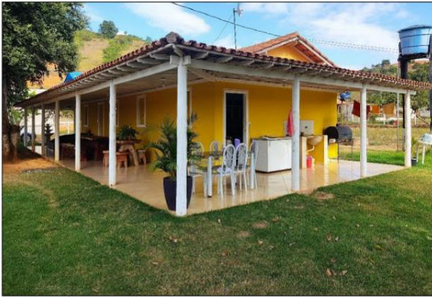
Foto 01. Estrutura de apoio.
