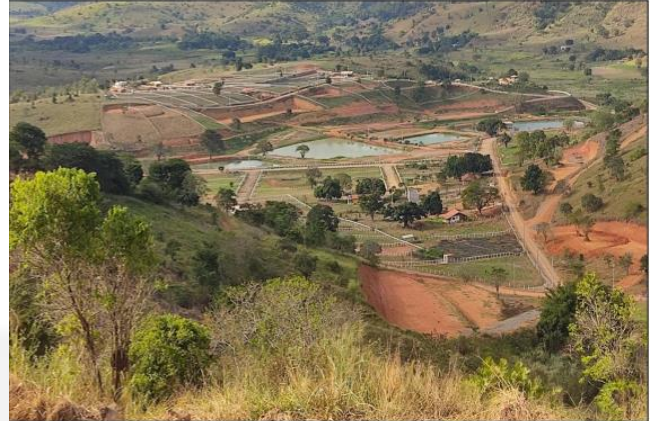
Foto 02. Visão geral do empreendimento.
