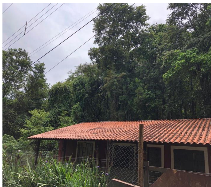
Imagens 01 a 05: Demonstram a vista frontal do terreno e a área demarcada para intervenção.
