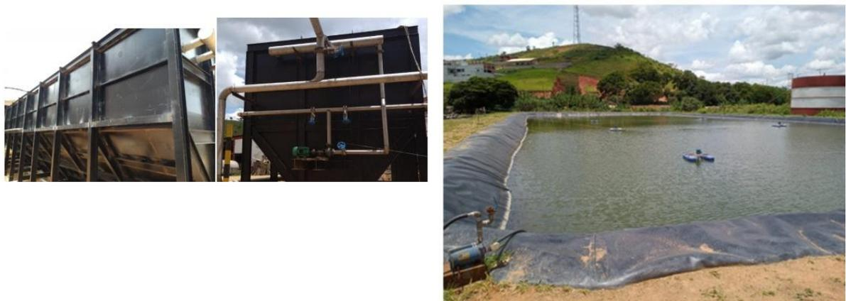
**Figura 09:** Tanque sedimentador (a esquerda) e lagoa aerada (a direita), com os aeradores instalados **Fonte:** informações complementares.
