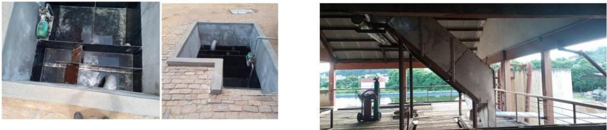
**Figura 08:** Etapas do tratamento preliminar ( a esquerda) e Peneira tipo "side Hill" (a direita). **Fonte:** informações complementares.
