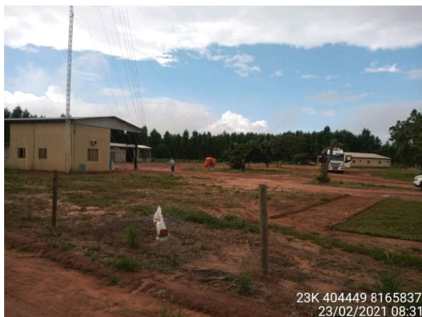
Foto 01: Área de apoio.
