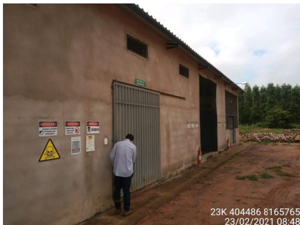
Foto 03: Galpão de armazenamento de agrotóxicos.
