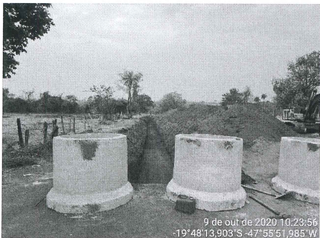
Figura 01: Início das obras no loteamento.
