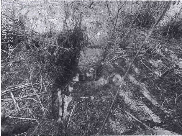
Figura 05: Vista do local requerido para as obras do emissário de esgoto e dissipador de energia no interior da APP.
