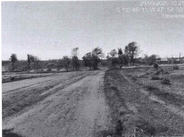
Figura 01: Vista da área do Loteamento “Jardim Parque das Oliveiras” que passará por supressão, fora de APP.
