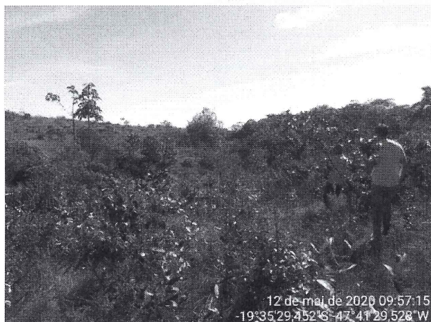
Figura 01: Vista parcial do empreendimento, com ênfase para a vegetação existente no local de construção do barramento.
