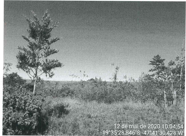
Figura 06: Vista parcial do empreendimento, com ênfase para a vegetação existente no local de construção do barramento.
