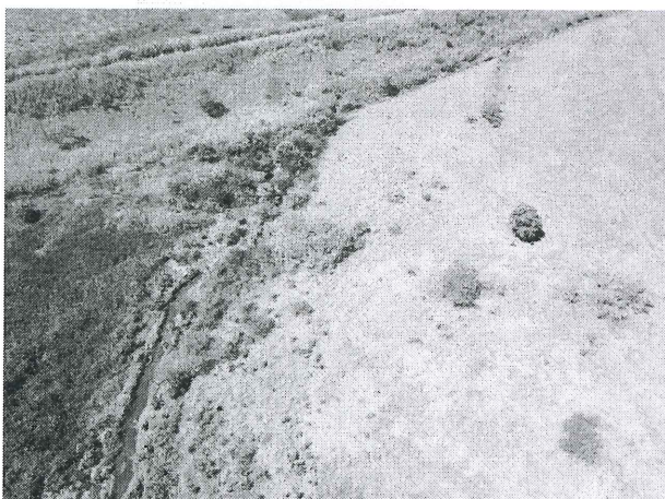
Figura 09: Vista parcial do empreendimento (área dos dissipadores 3 e 4).
