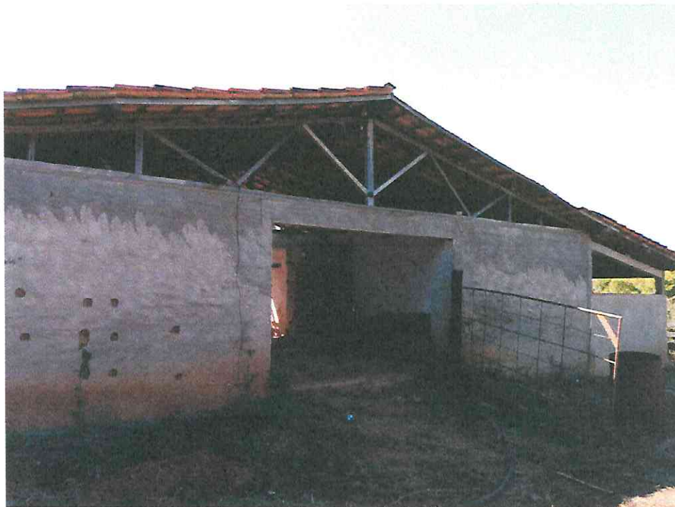
Figura 3: Atual construção e suas subdivisões em baias.
