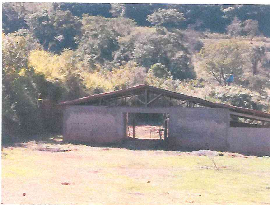
Figura 2: Construção em alvenaria e possível área para manutenção em maquinários.
