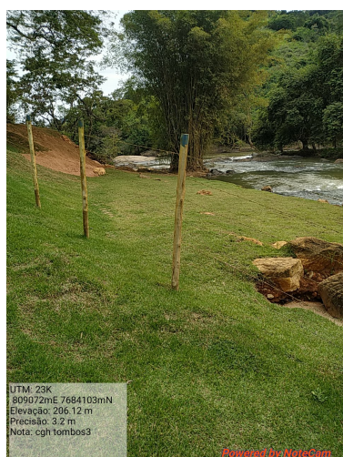
Intervenção em app sem supressão para otimização da zona de retorno ao rio da água
