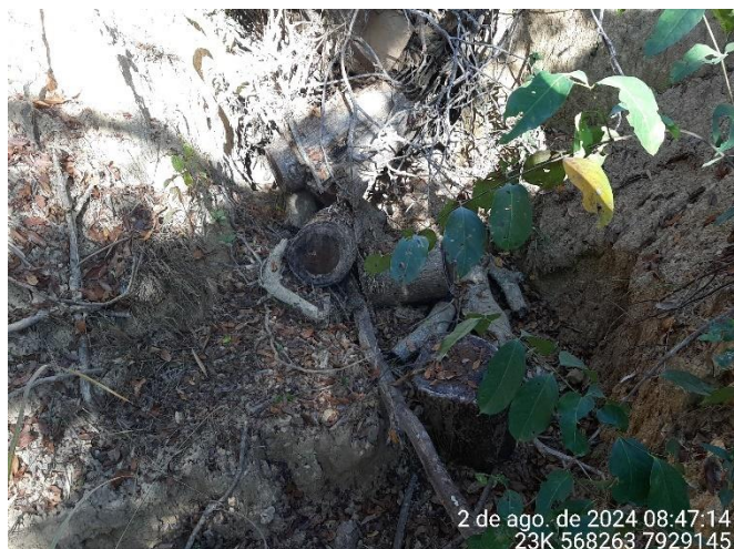
Foto 44: Material lenhoso disposto inadequadamente dentro de vala de processo erosivo.
