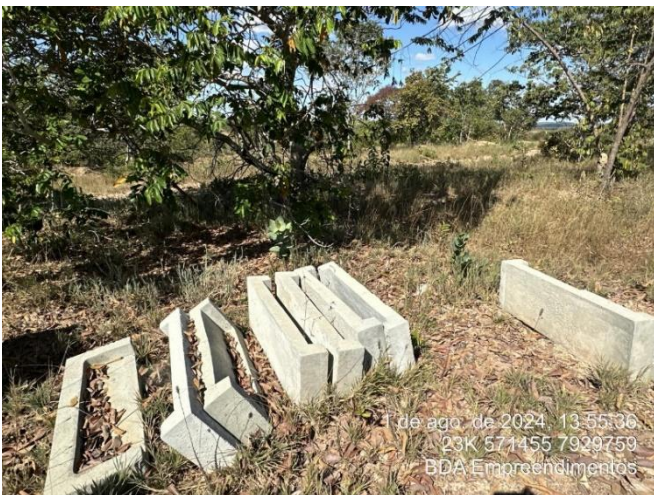
Foto 35: Estruturas de concreto a serem utilizadas no sistema de drenagem.
