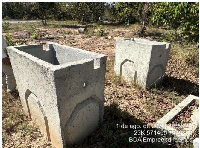
Foto 36: Caixas de concreto a serem instaladas nos pontos onde há bueiros, para receberem os sedimentos carregados.
