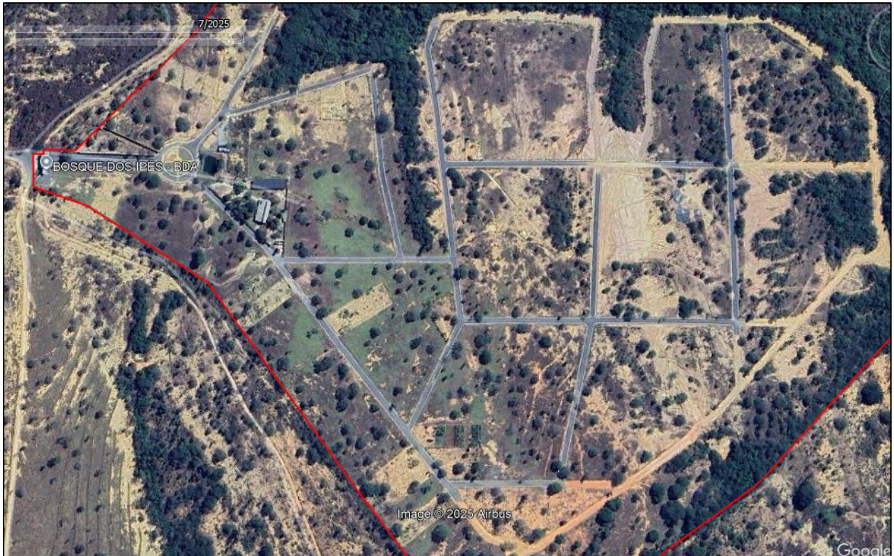
Figura 5. Abertura de vias e pavimentação
