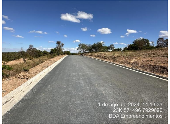
Foto 8: Uma das vias já totalmente asfaltada.
