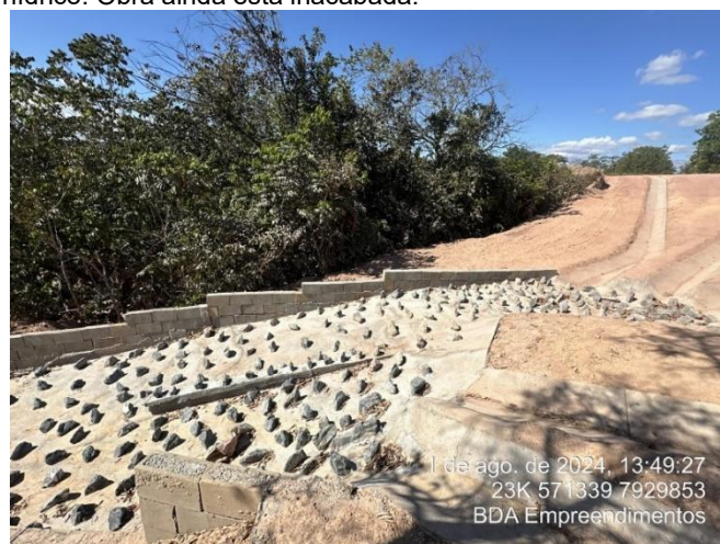
Foto 28: Outra vista da área implementada pela BDA, para corrigir erosões.
