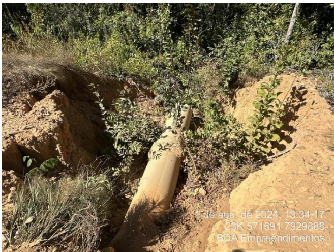
Foto 25: Ponto de desaguamento dos efluentes advindos de toda a drenagem superficial da BDA.
