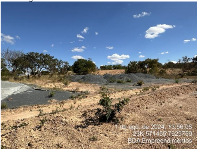
Foto 33: Pátio utilizado como canteiro de obras, com pilhas de brita.
