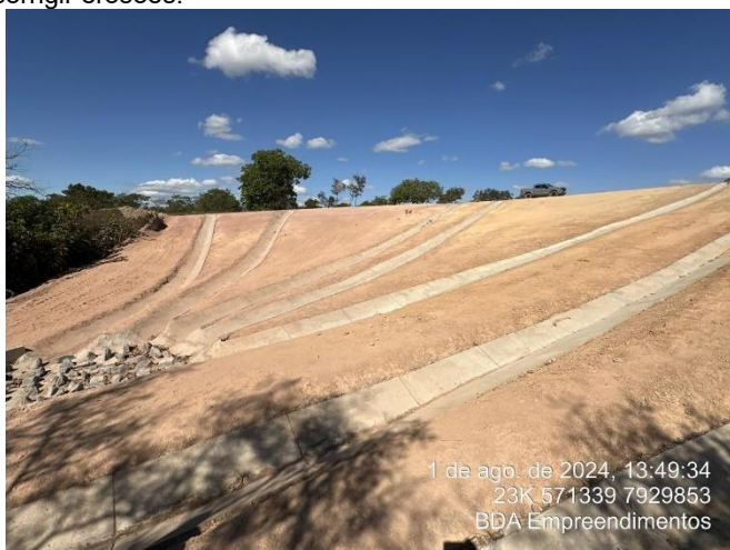
Foto 29: Área entre as canaletas de concreto ainda em solo exposto. O empreendedor informou que será plantada grama.
