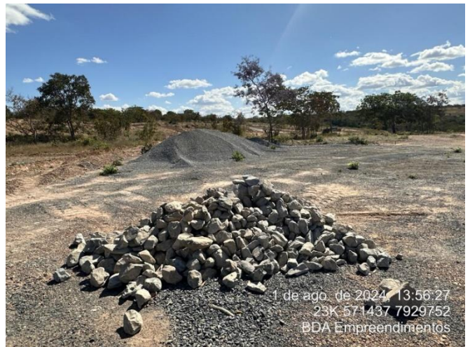
Foto 34: Pedra de mão e brita dispostas no canteiro de obras.
