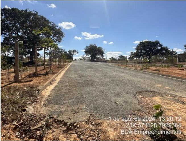
Foto 7: Uma das vias pavimentada parcialmente do loteamento.
