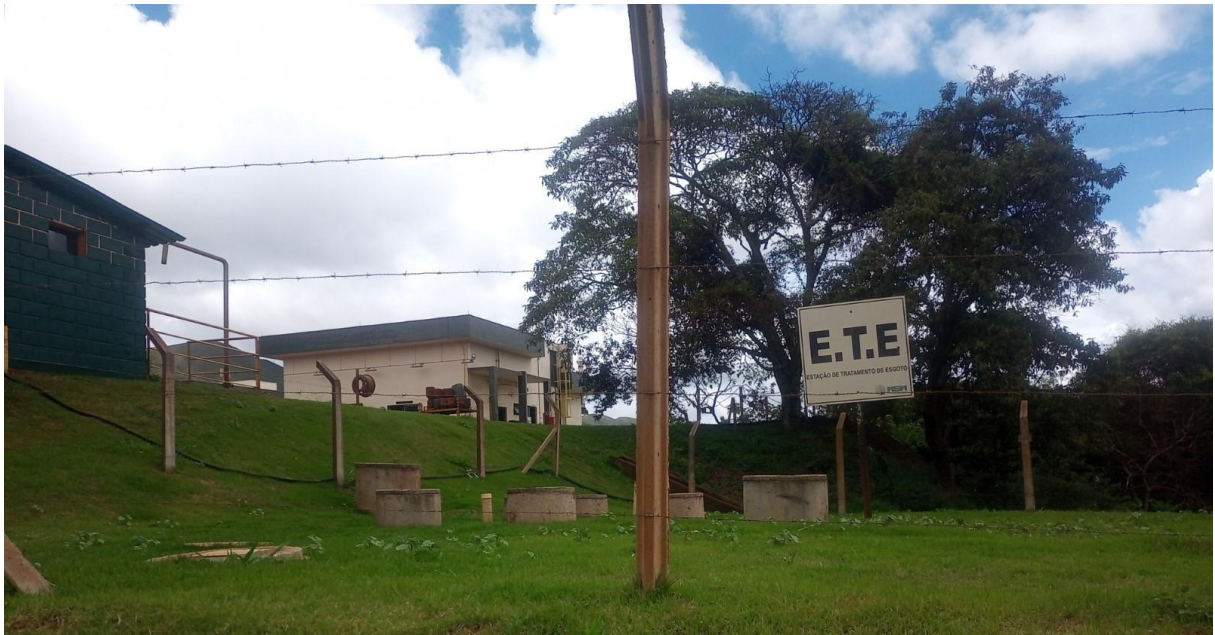
Figura 59: Vista do sistema de tratamento de efluentes sanitários. Fonte: Auto de Fiscalização nº 243153/2024.
