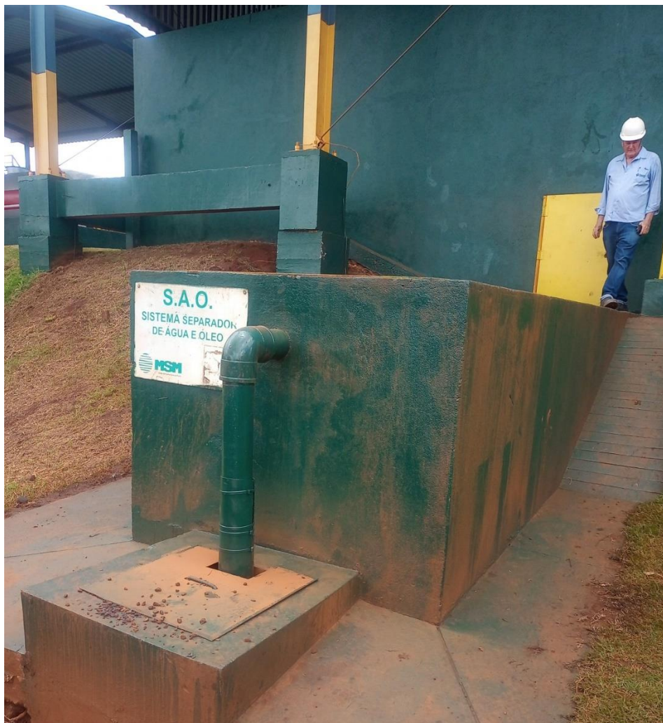
Figura 60: Vista da Caixa SAO.
