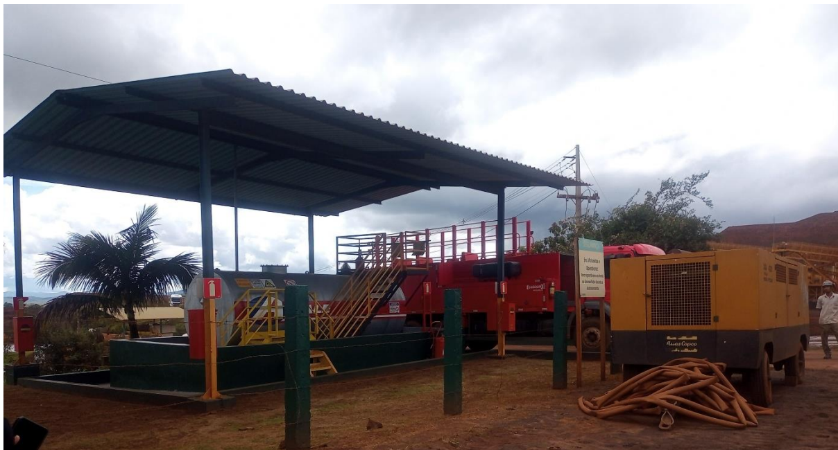
Figura 26: Vista do posto de abastecimento. Fonte: Auto de Fiscalização nº 243153/2024.
