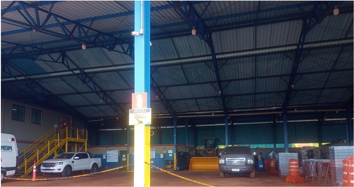
Figura 27: Vista da oficina de veículos. Fonte: Auto de Fiscalização nº 243153/2024.
