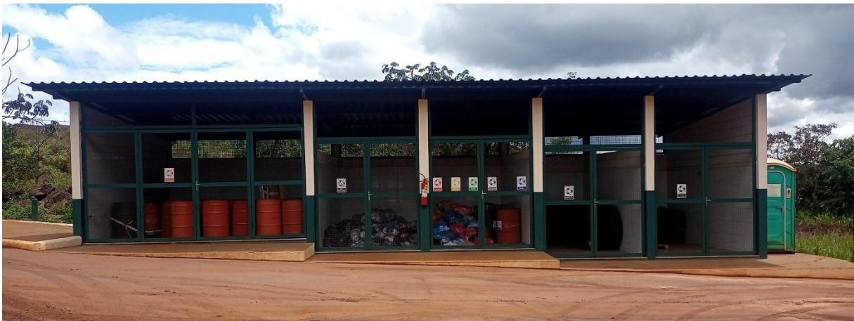
Figura 62: Vista do depósito de resíduos. Fonte: Auto de Fiscalização nº 243153/2024.
