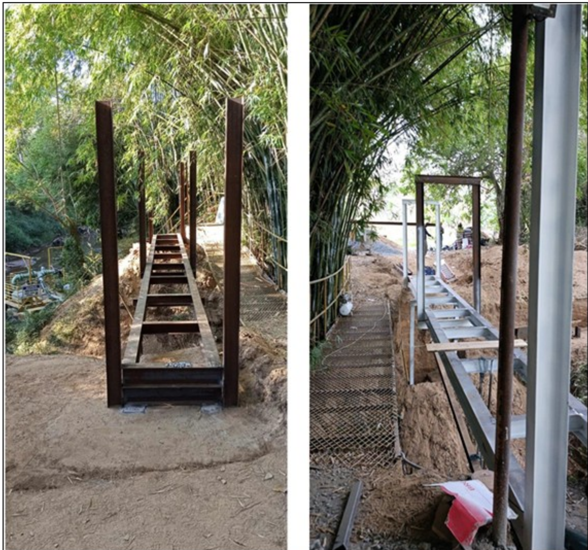
Fig.2 - Vista da área durante as obras emergenciais (Imagem cedida pelos autores dos estudos).
