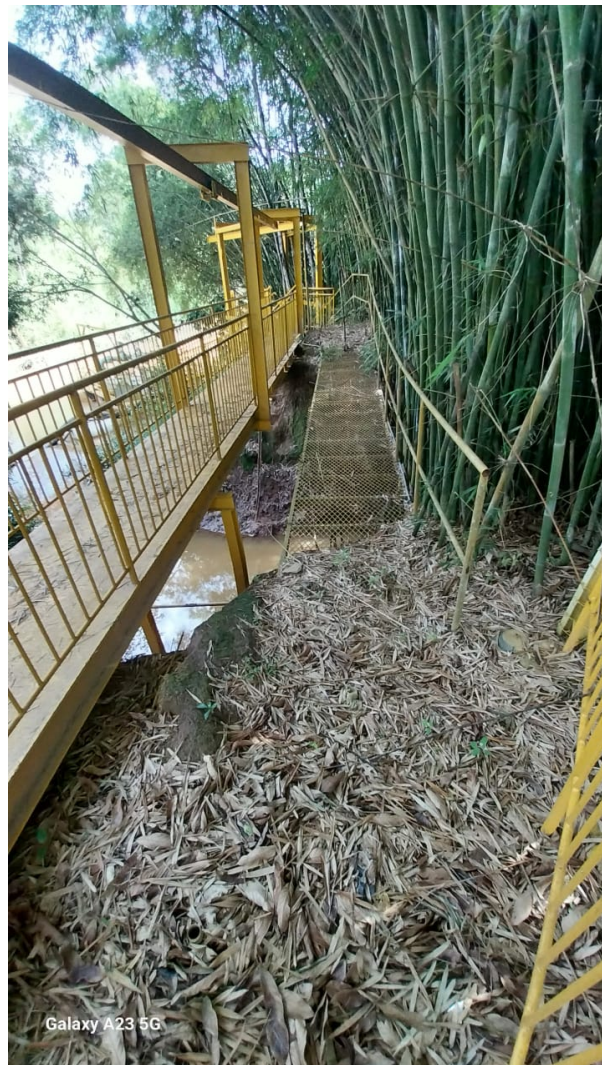
Fig.4 - Área de Intervenção após a instalação da nova passarela.
