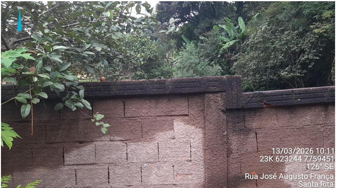
Foto 5 – Muro da residência.
