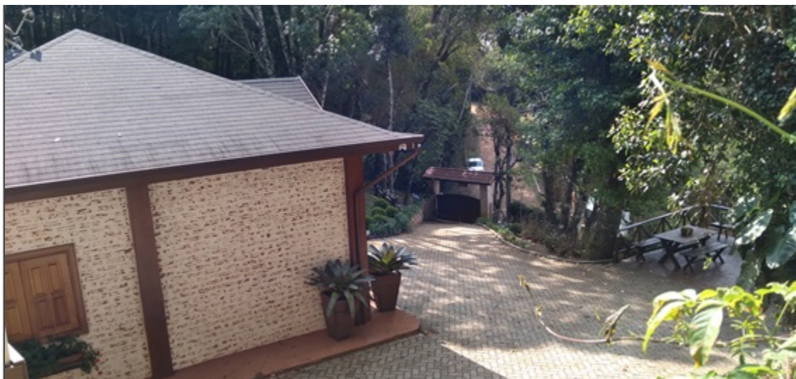
FIGURA 14: Imagem da propriedade vizinha ao Lote nº. 16 da Quadra H, no Loteamento Recanto do Selado, Distrito de Monte Verde, Camanducaia/MG, pertencente ao Sr. Rutherford Gonzaga Morais.
