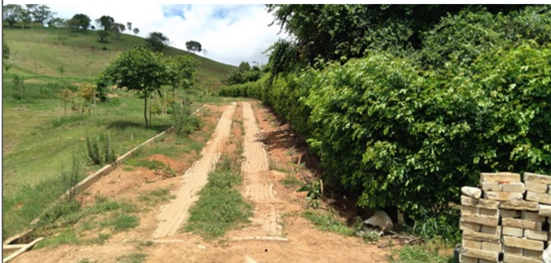
FIGURA 10: Imagem da intervenção ambiental em APP, construção de cerca de alambrado e sistema de drenagem pluvial, na Chácara Anhumas, Bairro Anhumas, município de Pedralva/MG.
