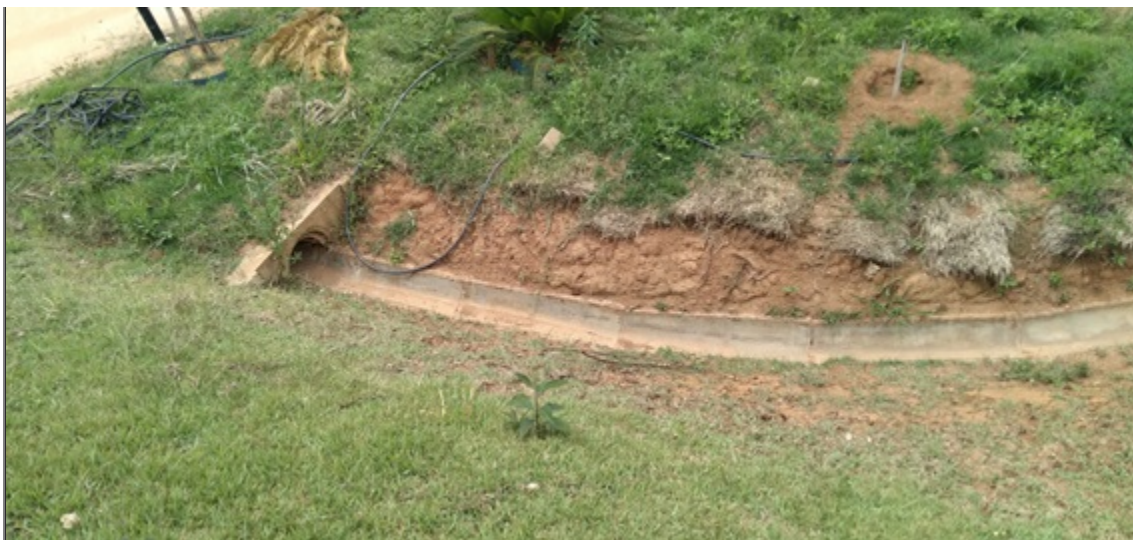
FIGURA 06: Local da intervenção ambiental em APP, construção de sistema de drenagem de águas pluviais, na Chácara Anhumas, Bairro Anhumas, município de Pedralva/MG.
