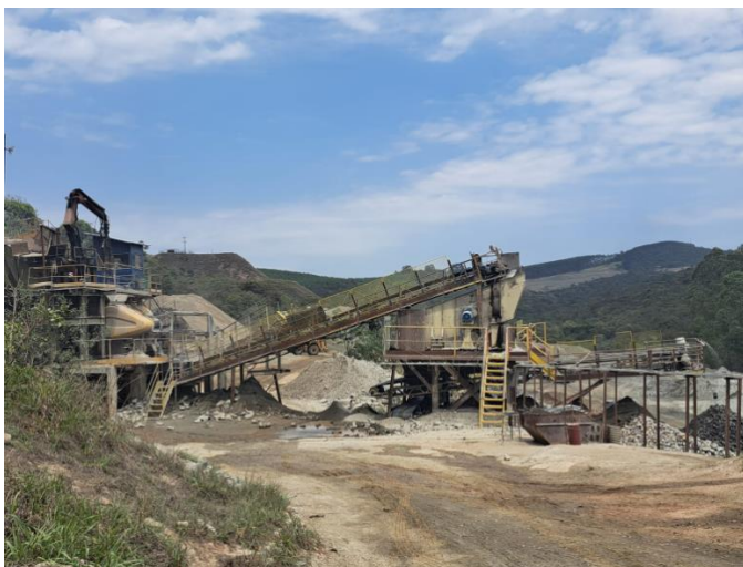
Foto 03: Vista parcial da UTM a seco.
