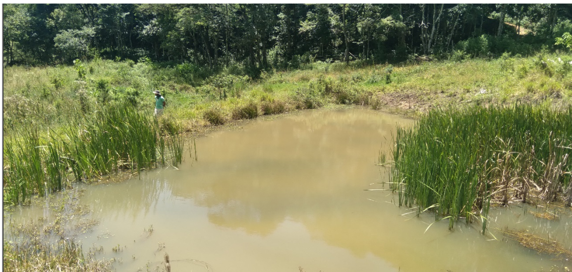
FIGURA 10: Local da intervenção ambiental, construção de construção de dois açudes, no Sítio Mariana, Bairro Guabirola, município de Bueno Brandão/MG.
