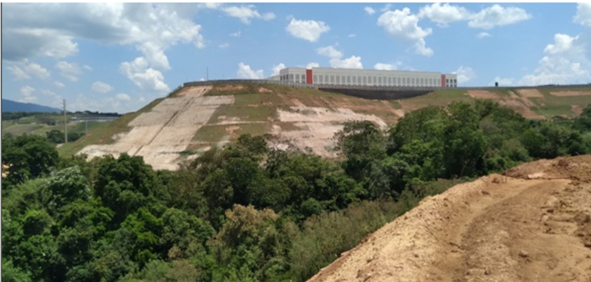
FIGURA 04: Panorâmica da Área Diretamente Afetada (ADA) do empreendimento, construção de ponte, em APP na propriedade Gleba nº. 01, bairro dos Pessegueiros, município de Extrema/MG.
