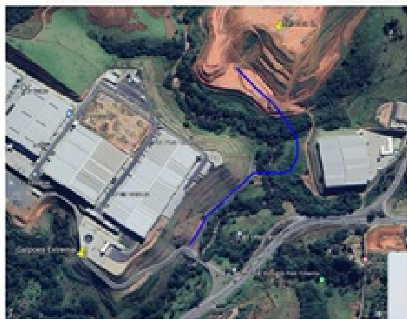
FIGURA 25: Imagem da Alternativa 4 de acesso ao empreendimento na propriedade Gleba nº. 01, bairro dos Pessegueiros, município de Extrema/MG.
